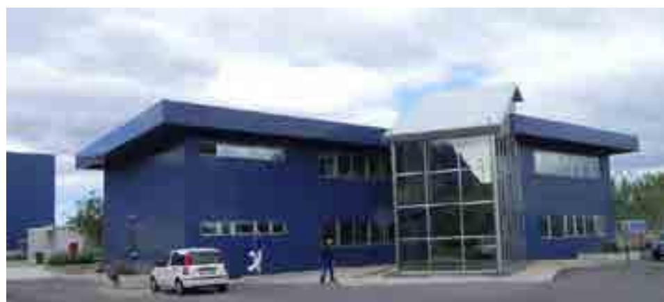
Termovalorizzatore di Acerra (NA)
